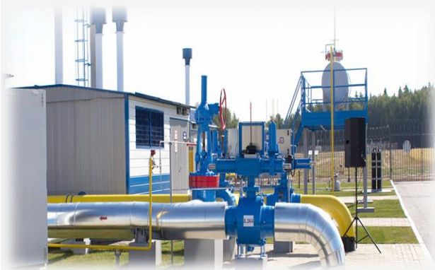
Проведение газопроводов и прокладка инженерных сетей в городском округе Семеновский
