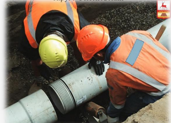
Инженерные коммуникации в городском округе Семеновский
