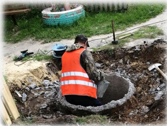
Реализация проектов «Вам решать!» Наружные сети водоотведения
