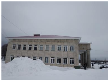
Капитальный ремонт кровли ДК с.И-Заборское
