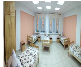
Капитальный ремонт МБУ ДО ДЗОЦ "Колос"
