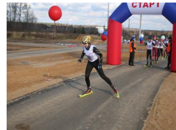
Устройство лыжероллерной трассы
