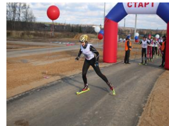
Устройство лыжероллерной трассы
