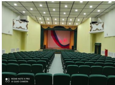
Капитальный ремонт ГДК р.п. Сухобезводное
