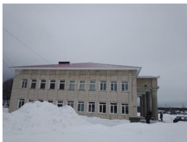
Капитальный ремонт кровли ДК с.И-Заборское
