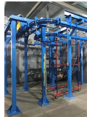
Новая линия порошковой окраски ОАО ЛМЗ
