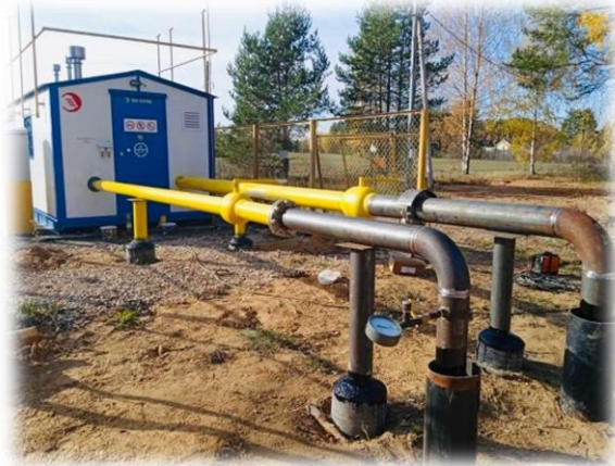
Проведение газопроводов и прокладка инженерных сетей в городском округе Семеновский
